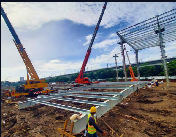
Proses Perakitan Sebelum Lifting
